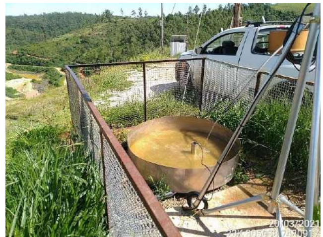
Foto 4 – Atividade de manutenção na EMA Barragem Pedreira. (Data: 20/03/2021).
