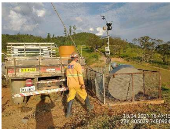
Foto 5 – Limpeza do tanque do reservatório e do medidor de nível. (Data: 15/04/2021).
