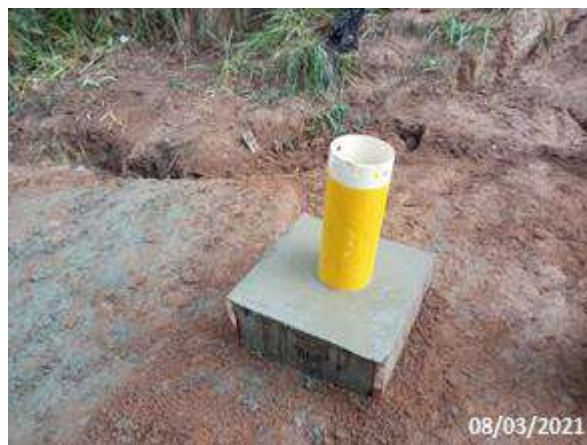
Foto 12 – Finalização do PM-BP-12. (Data: 08/03/2021).
