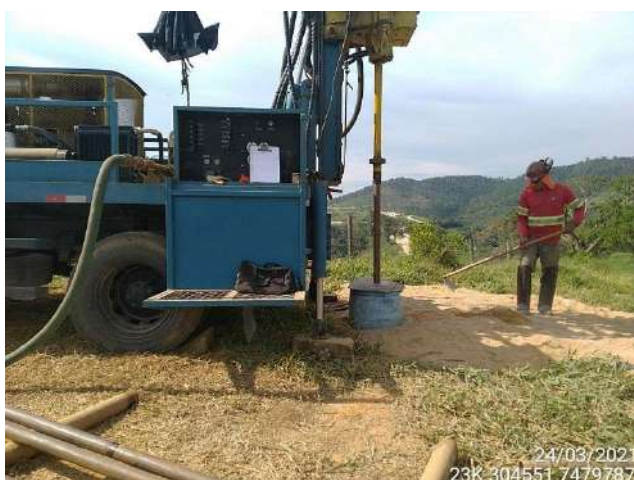
Foto 9 – Execução das atividades no PM-BP-09. (Data: 24/03/2021).
