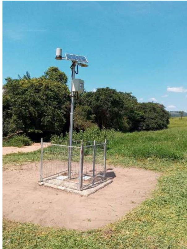
Estação Telemétrica Limpa (longe)
