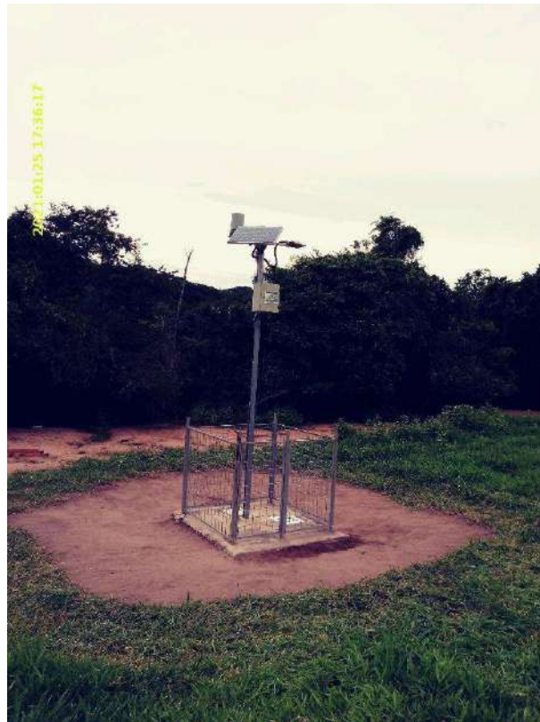
Estação Telemétrica Limpa (perto)
