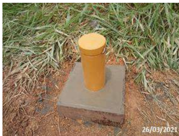
Foto 8 – Finalização do poço PM-BP-08. (Data: 26/03/2021).
