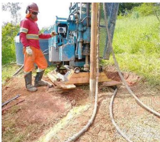
Foto 5 – Desenvolvimento das atividades de sondagem no PM-BP-05. (Data: 20/01/2021).
