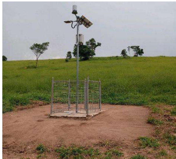
Estação Telemétrica Limpa (longe)
